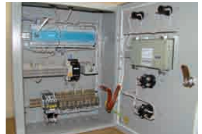
Фото 1. Щит автоматизации водогрейного котла ЩАК 1.0
