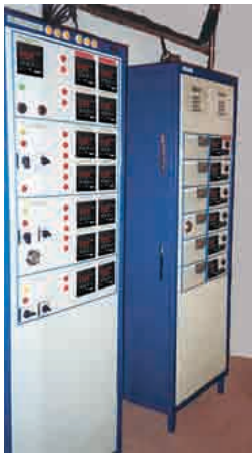
Шкафы управления системы ПОИСК-ТЕПЛО
