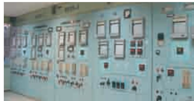
Фото 1. Щитовая, управляющая паровыми котлами
