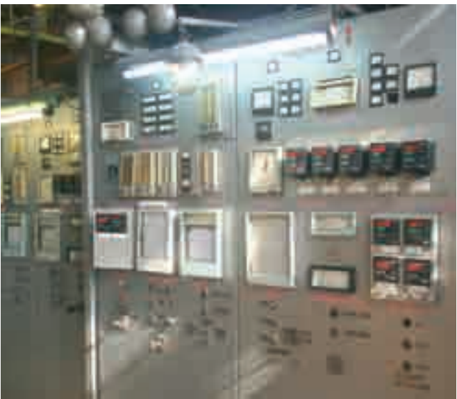
Фото 2. Щит управления паровым котлом №1
