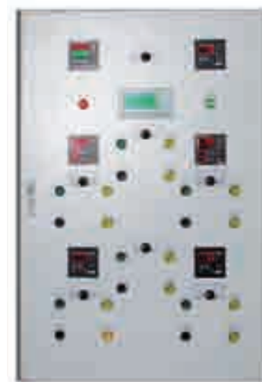
Фото. Шкаф управления холодным водоснабжением
