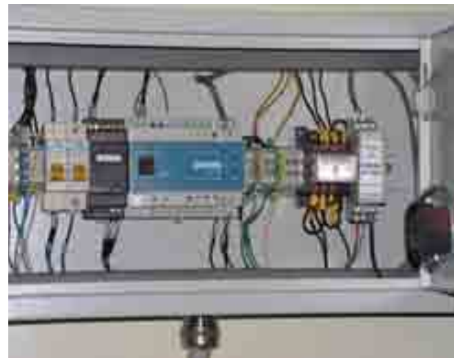
Рис. 1. Шкаф управления с контроллером ПЛК100
