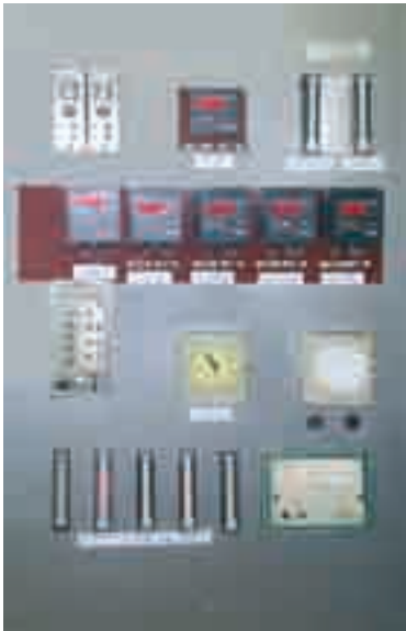
Фото 1. Щит управления станцией химической очистки воды
