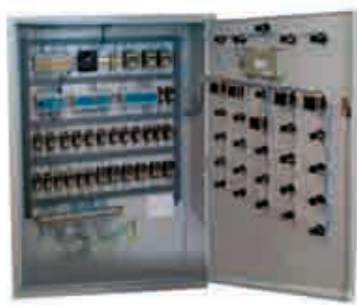
Фото 1. Щит управления котельной
